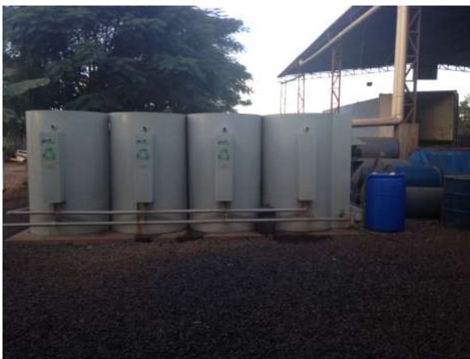
Figura 6. Estação de tratamento do efluente.
