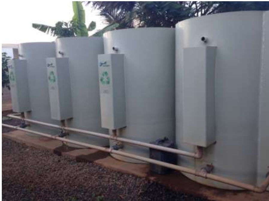
Figura 3. Estação de tratamento de efluente adotado no lavajado (Sistema Limpagua SKS).
